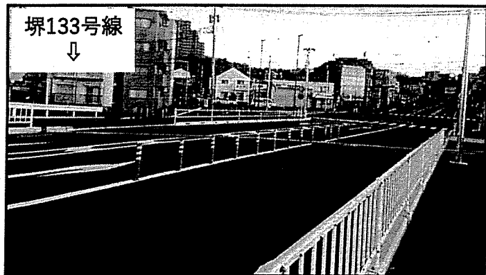
多摩ニュータウン入口交差点の手前に設置された車線分離標。この対応により、生活道路(堺133号線)を通過する車両が減少した。
