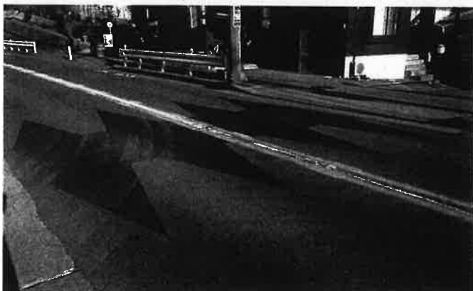
道路の振動対策(成瀬4丁目)
