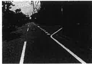
薬師台2丁目9~10番地 周辺の右側に路側帯の白 線を設置
