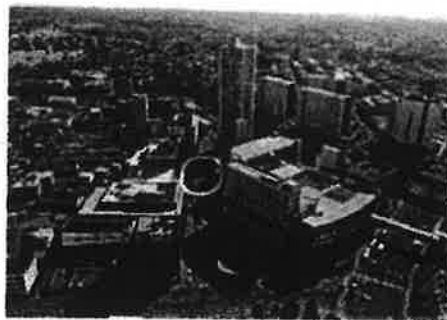
写真提供：大成建設
