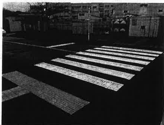
(小山田中学校前) 横断歩道の白線補修
