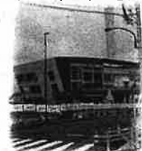
建設中の町田市バイオエネルギーセンター
