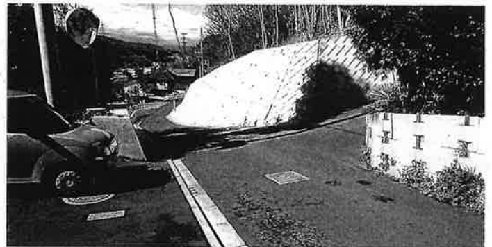
野津田綾部原875番地付近の工事完成写真
