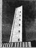
山崎団地センターバス停付近の「町田木曾住宅第2給水塔」は2021年5月下旬にかけて解体され、跡地に「コミュニティ型生活サービス拠点」が建設される予定です。
