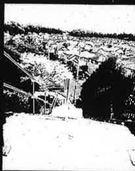
▲施工後の階段上から
