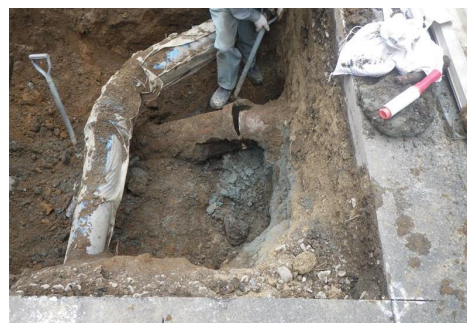
左官工法による補修の様子
