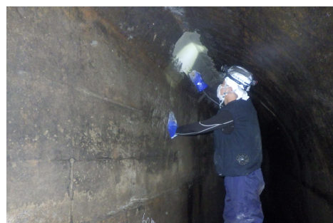
左官工法による補修の様子
