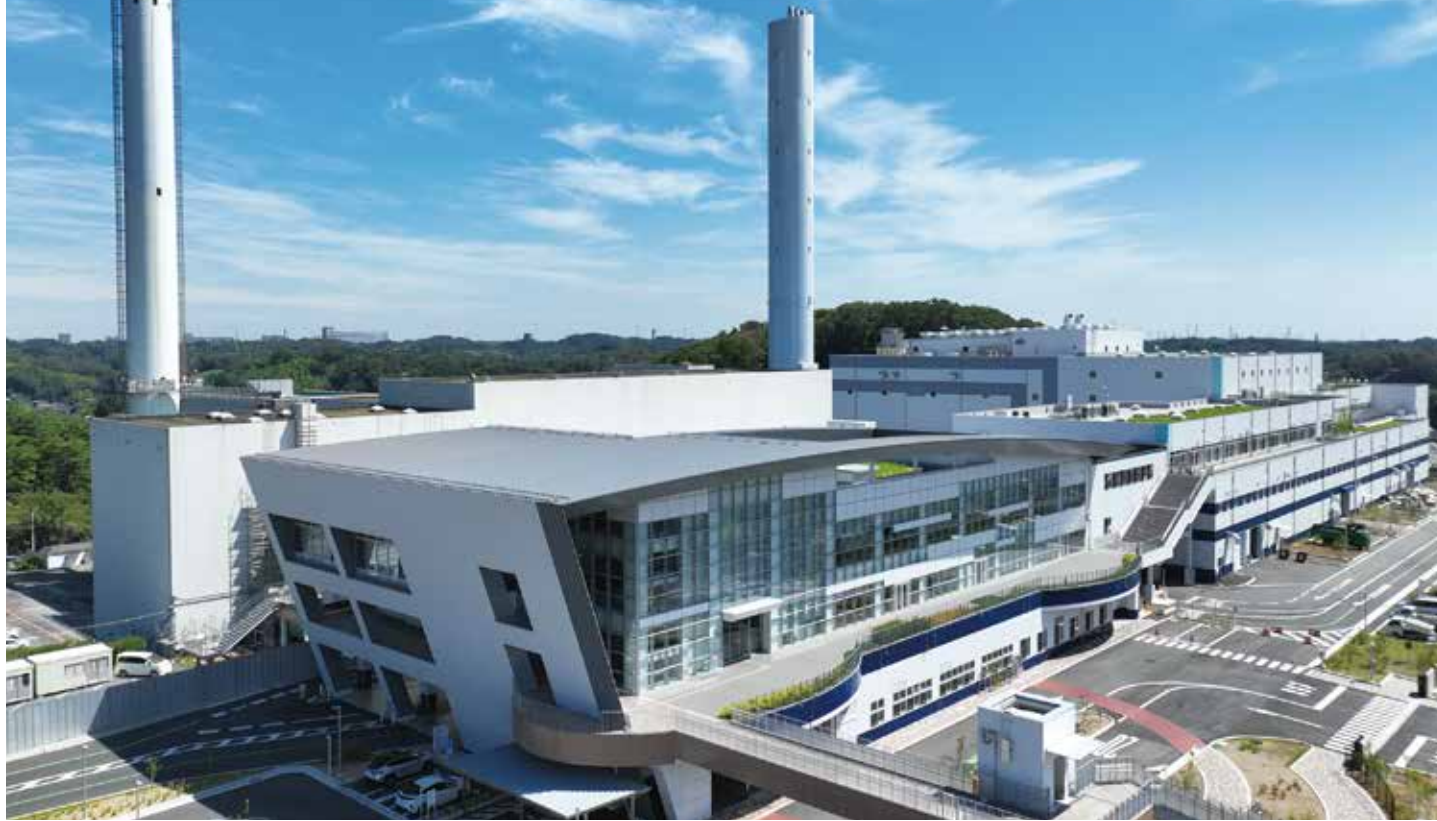
愛称が「バイエネ君」に決定した町田市バイオエネルギーセンター
