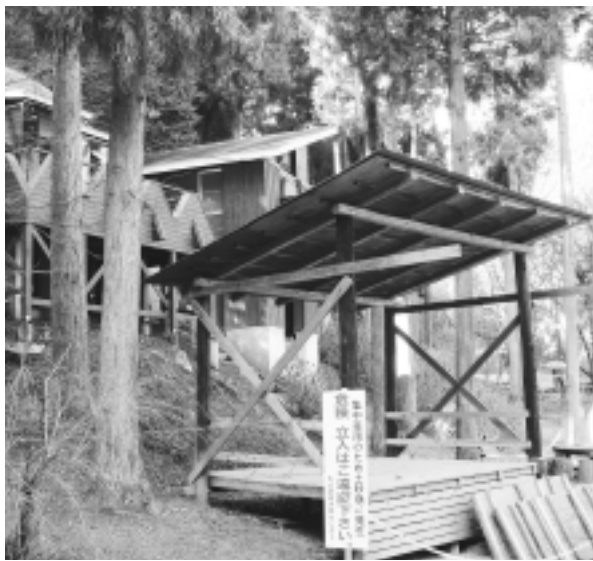
復旧工事中の大地沢青少年センター
