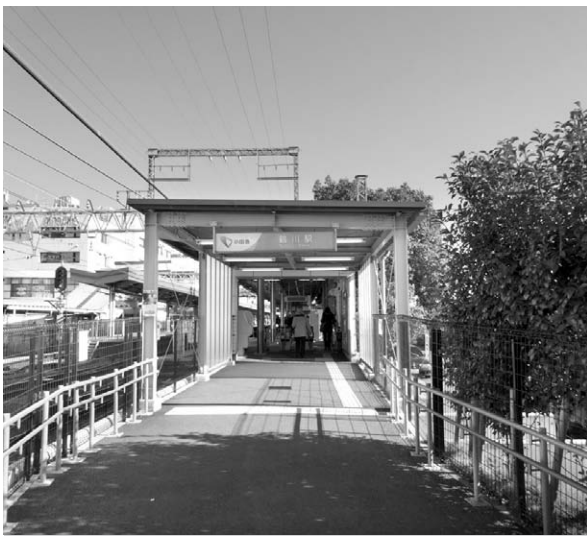
小田急線鶴川駅南口改札口の様子
