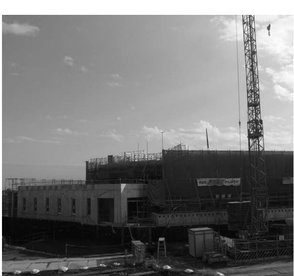
建設中の小山中学校
