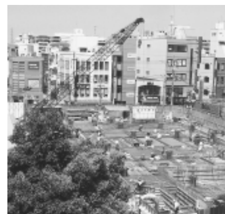
公民館が入る建物の建築現場
