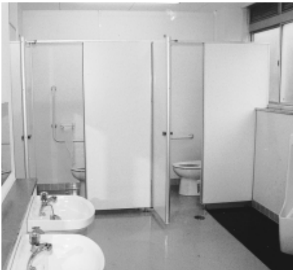
改修された小学校のトイレ（本町田小学校）
