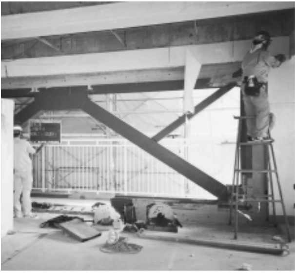
耐震補強工事(南第三小学校)
