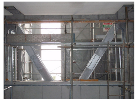
図8. 耐震プレス補強
