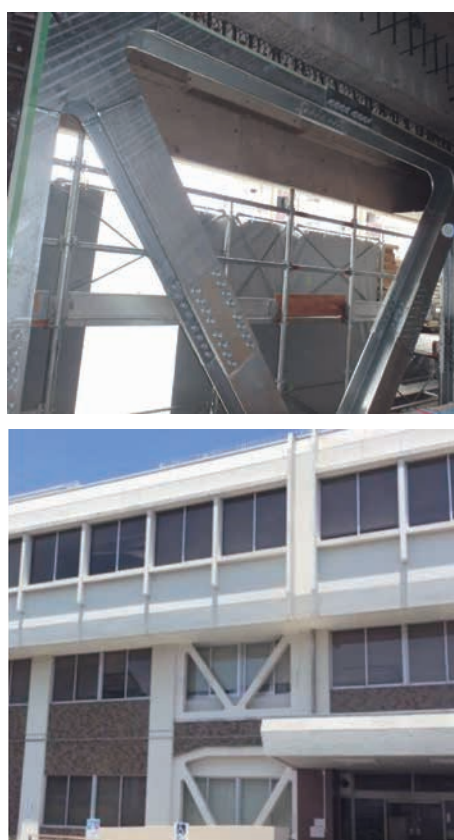
図6-5 耐震補強工事中の建物（上） 耐震化工事完了後の建物（下）
