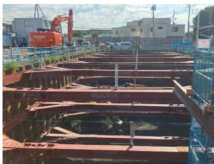
雨水調整池工事 (区画整理事業)
