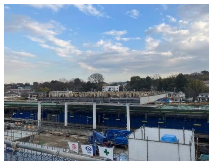
駅舎の鉄骨工事
