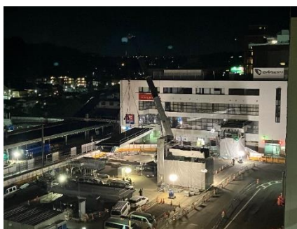
自由通路の架設工事
