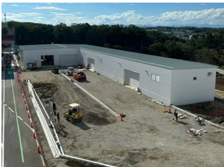
ストックヤード棟建築工事状況 【工事状況写真】
