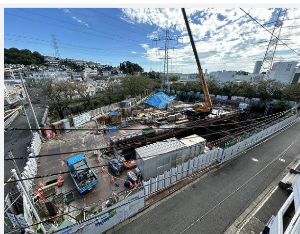
9月2日の建設地
