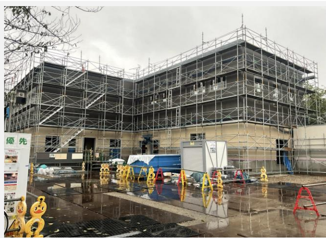
８月３０日の建設地
