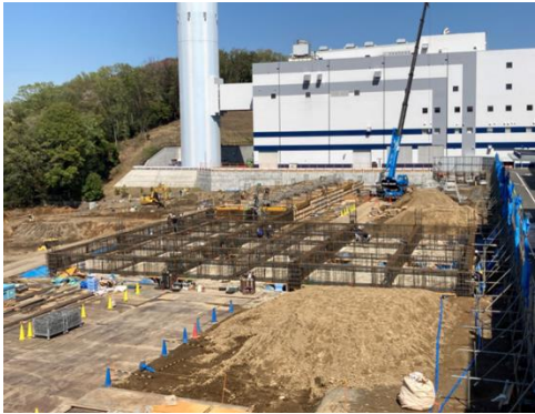
ストックヤード建築工事状況 （基礎躯体工事）
