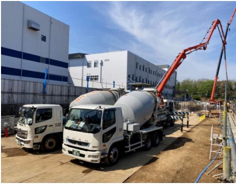
ストックヤード建築工事状況 （コンクリート打設）
