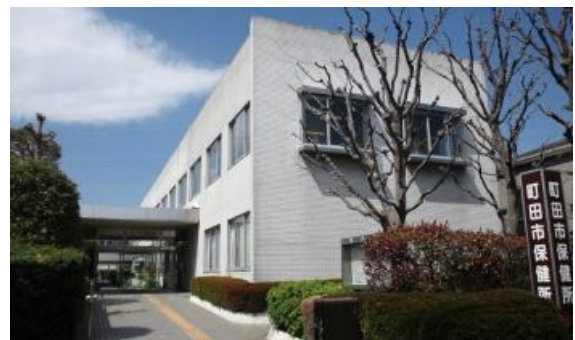
保健所中町庁舎
