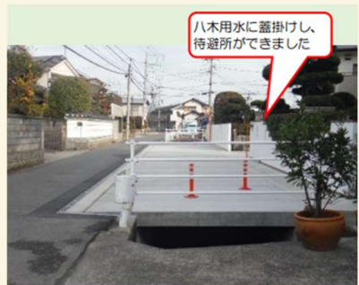
幅員の狭い道路の改良
