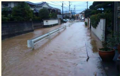
土石流に運ばれた土砂が用水に堆積し、 周辺の住宅が浸水被害を受けた様子
