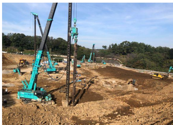
杭の引抜状況
