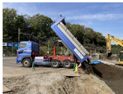
ストックヤード棟建設に伴う土の搬入
