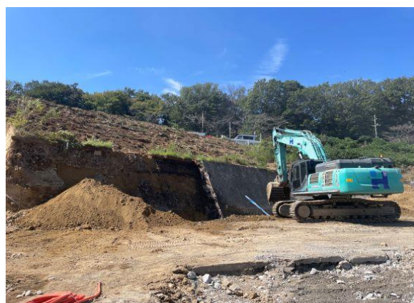
擁壁解体状況
