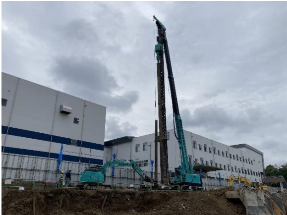
杭の引抜状況
