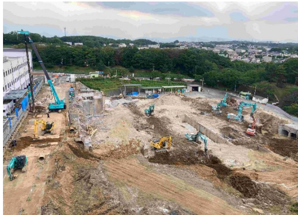
解体工事状況
