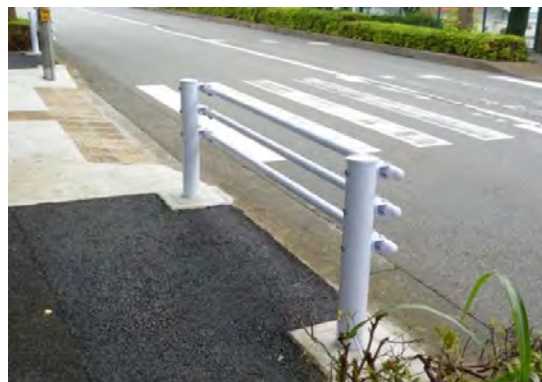
横断抑止柵設置
