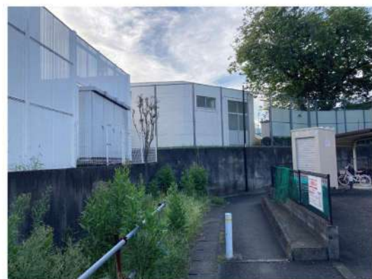
⑧南側歩道
