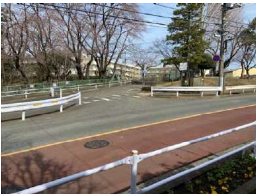
② 2-2 南側歩道（正門）
