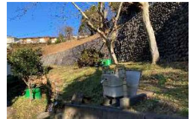
【敷地周囲の急な傾斜】
