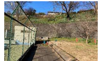
【敷地周囲の急な傾斜】
