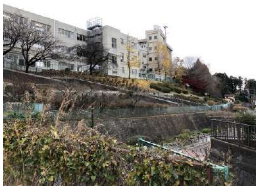
⑦校舎西側の斜面
