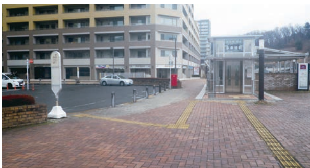
▲多摩境駅前広場のエレベーター
