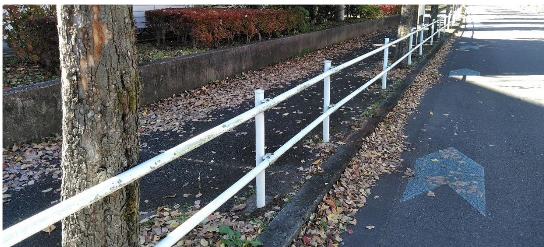
写真 車道、歩道に落葉が堆積している状況
