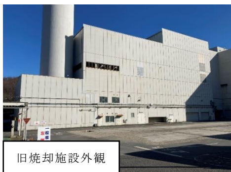
【旧焼却施設解体工事写真】
