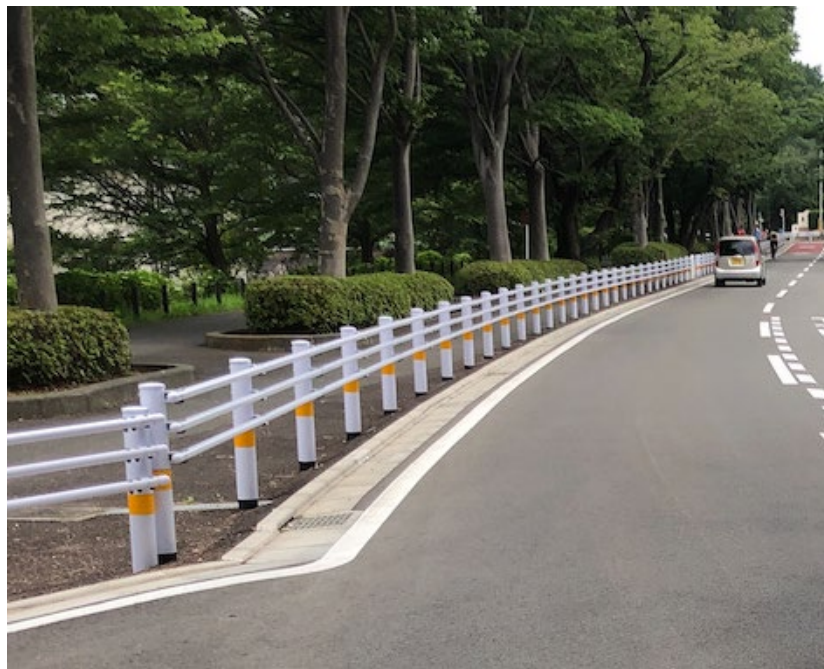
図 3-2-5 ガードパイプと横断抑止柵の設置
