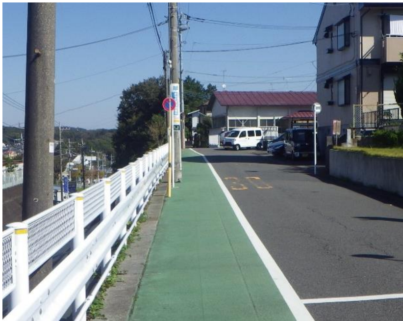
図 3-2-4 カラー舗装の実施
