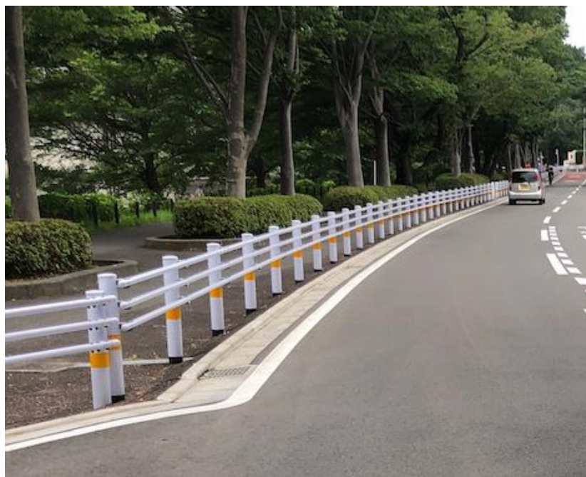
図 3-2-5 ガードパイプと横断抑止柵の設置
