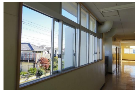
(防音対策工事)建具を防衛省適合防音建具に交換
