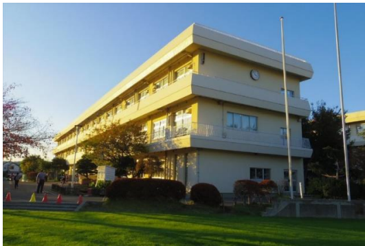
(外壁の外断熱化)外壁に断熱材50mmを施工
