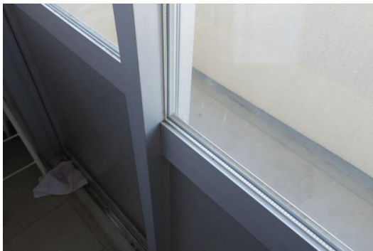
(外部開口部の断熱化)建具を二重ガラス化
