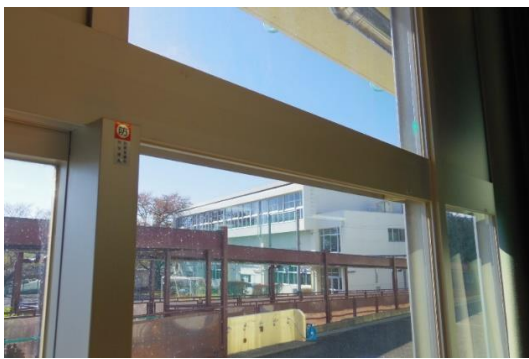
(防音対策工事)建具を防衛省適合防音建具に交換
