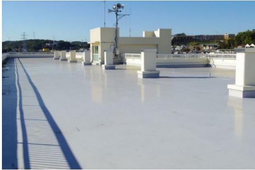
(屋上の外断熱化)防水下に断熱材25mmを施工
