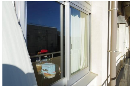
(外部開口部の断熱化)建具を二重ガラス化
